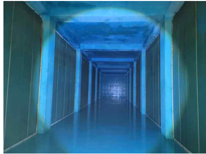
<배수지 2지 전경>
