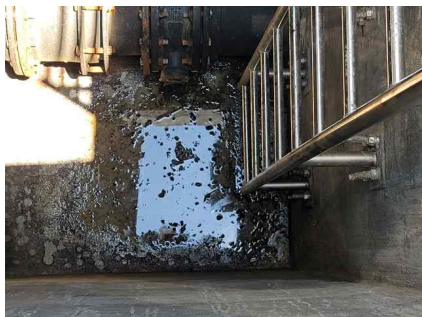
<유입밸브실 1지 바닥슬래브 채수>
