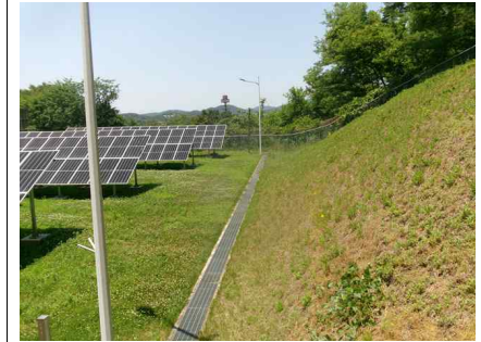
<부대시설 배수로 전경>
