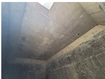
<유량계실 상부슬래브 상태양호>
