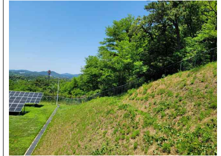
<부대시설 사면(성토부) 상태현황>
