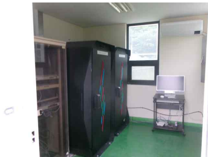
<건축동 내부 전경>
