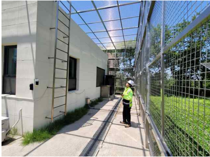
<외부 개별부재 외관조사>
