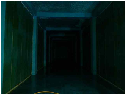
<배수지 1지 전경>
