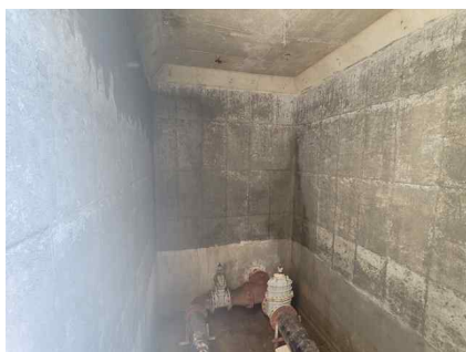
<통합유출밸브실 전면 벽체 상태양호>
