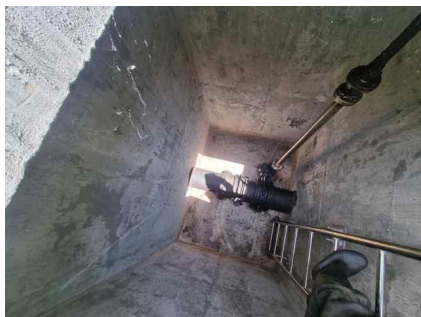
<유입밸브실 2지 상태양호>
