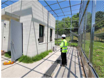
<외부 개별부재 외관조사>
