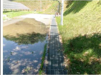
<부대시설 배수로 상태현황>
