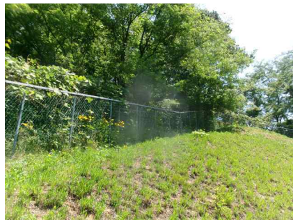
<부대시설 안전펜스 전경>
